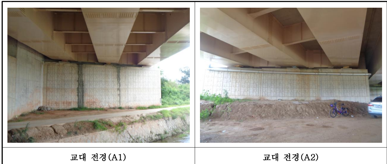
【사진 13.3.8】 교대 전경
