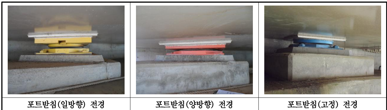
【사진 13.3.31】 교량받침 전경
