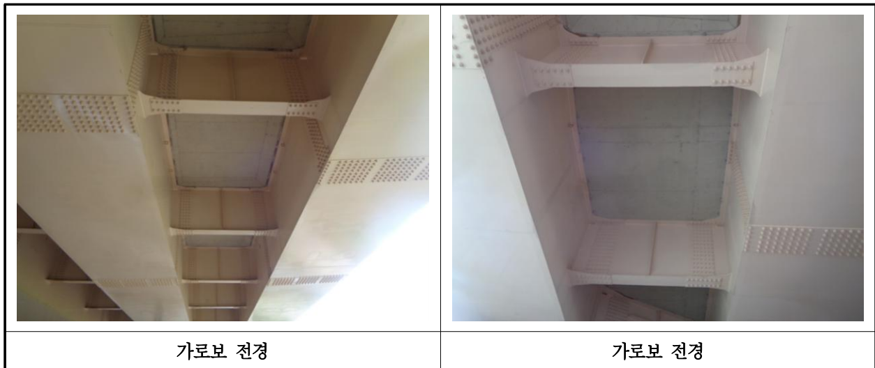
【사진 13.3.6】 가로보 전경
