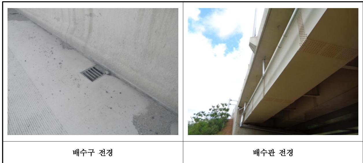
【사진 13.3.19】 배수시설 전경
