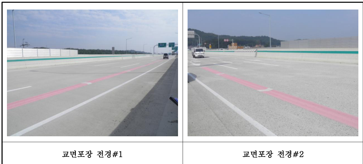
【사진 13.3.17】 교면포장 전경
