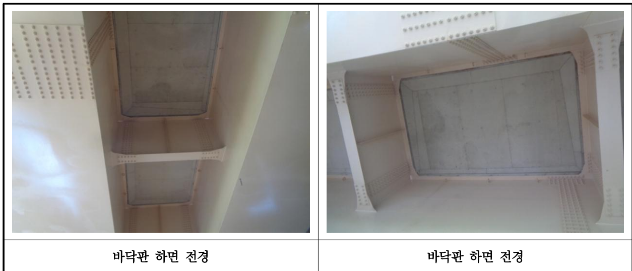
【사진 13.3.23】 바닥판하면 전경
