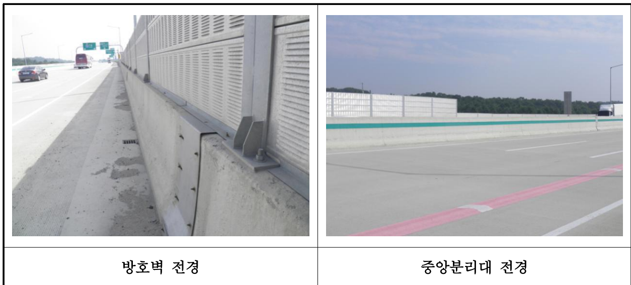
【사진 13.3.21】 방호벽 및 중앙분리대 전경
