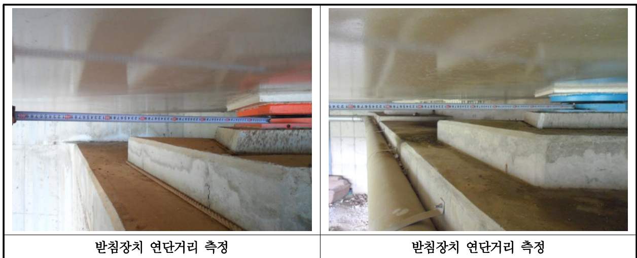
【사진 13.3.12】 교량받침장치 연단거리측정
