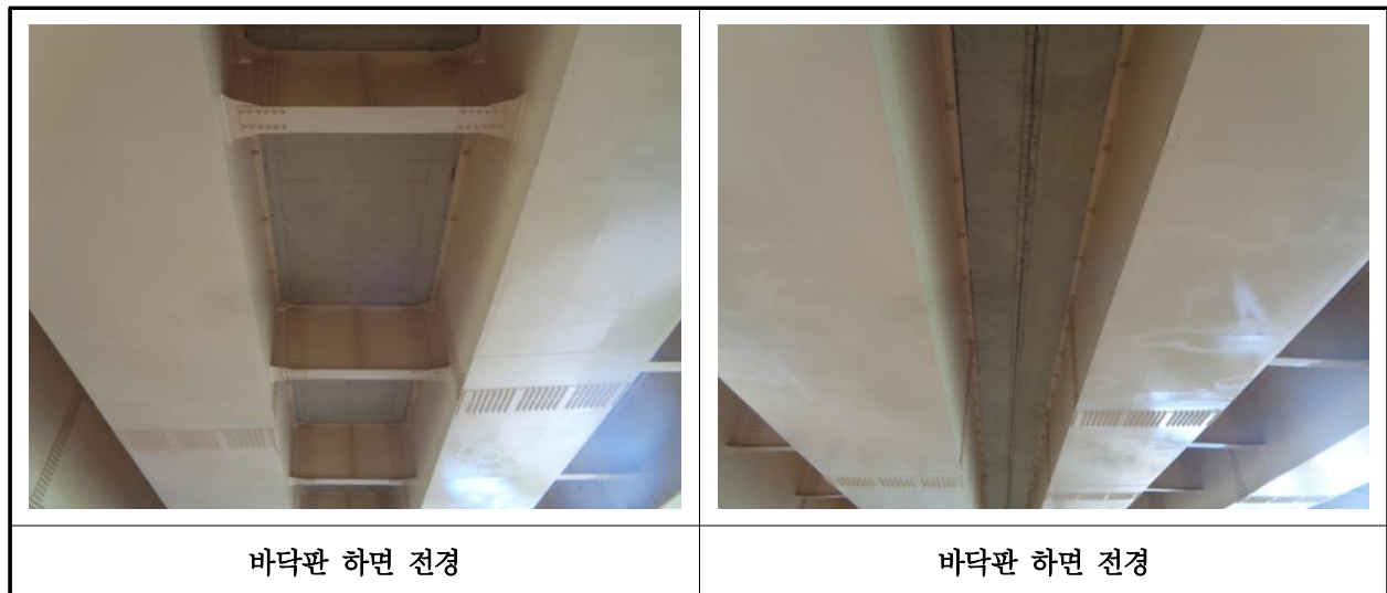
【사진 13.3.2】 바닥판하면 전경
