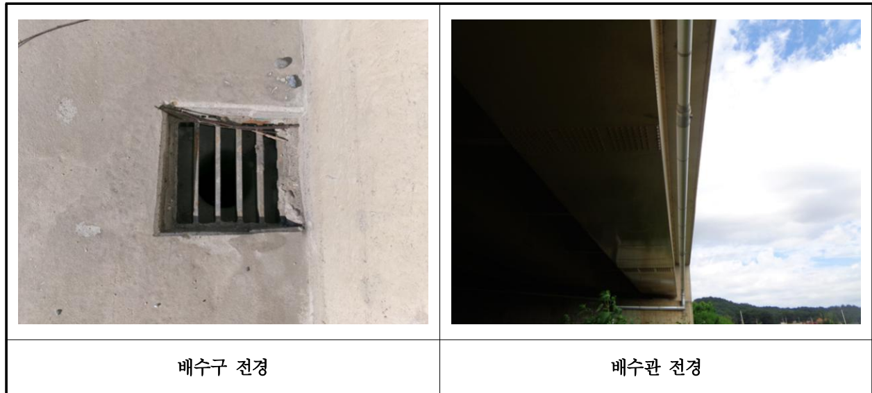
【사진 13.3.40】 배수시설 전경
