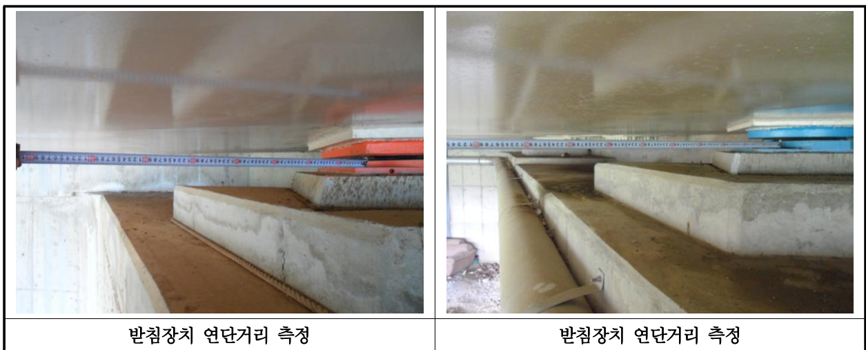
【사진 13.3.33】 교량받침장치 연단거리측정
