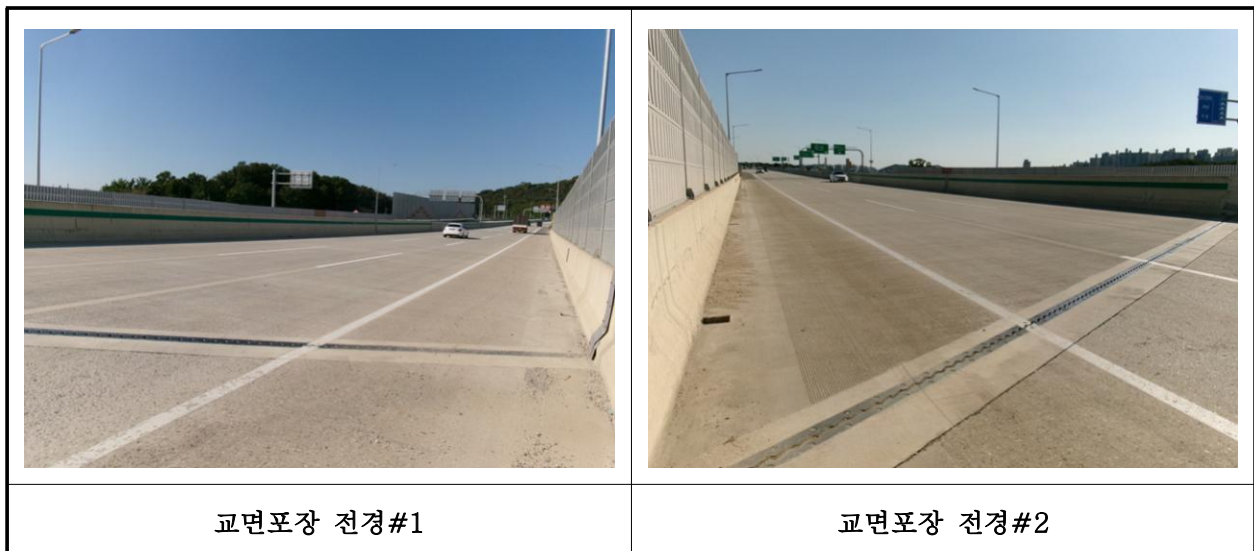
【사진 13.3.38】 교면포장 전경
