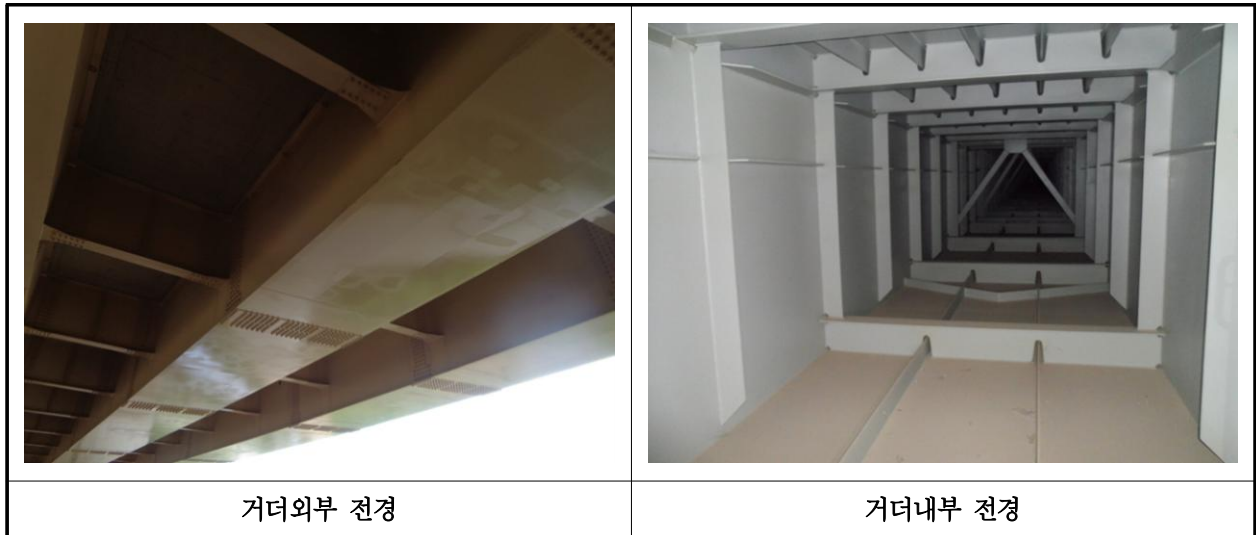
【사진 13.3.4】 거더 전경
