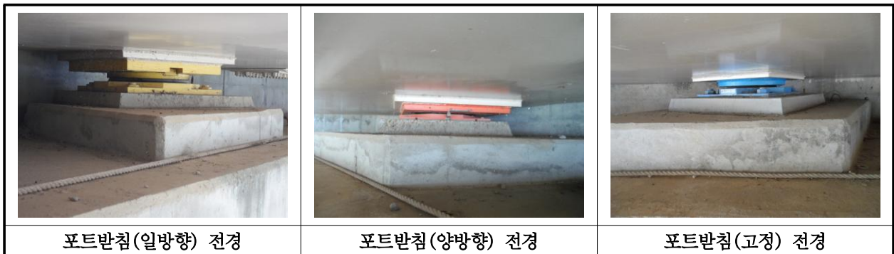
【사진 13.3.10】 교량받침 전경
