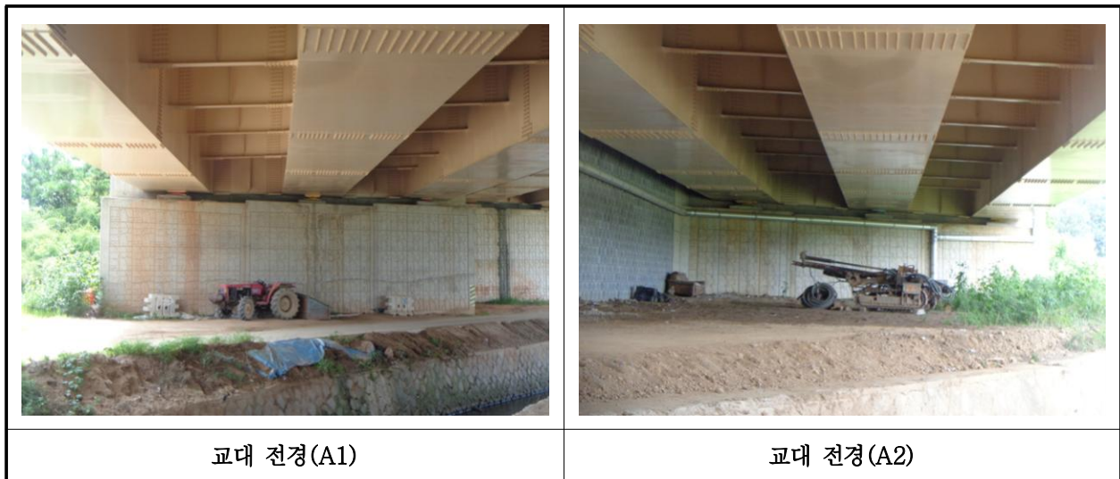
【사진 13.3.29】 교대 전경
