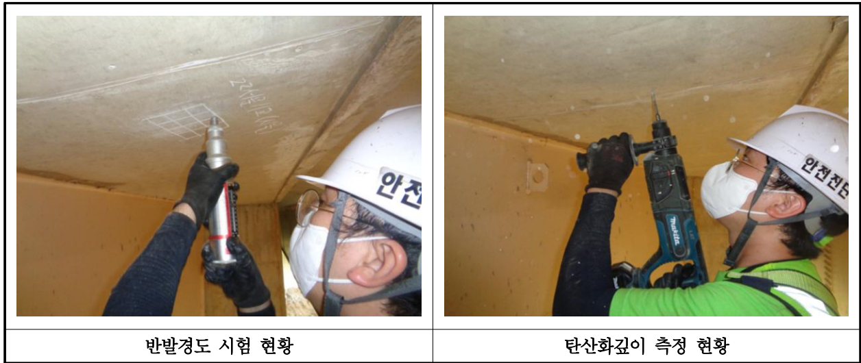
【사진 13.4.1】 콘크리트 내구성조사 현황
